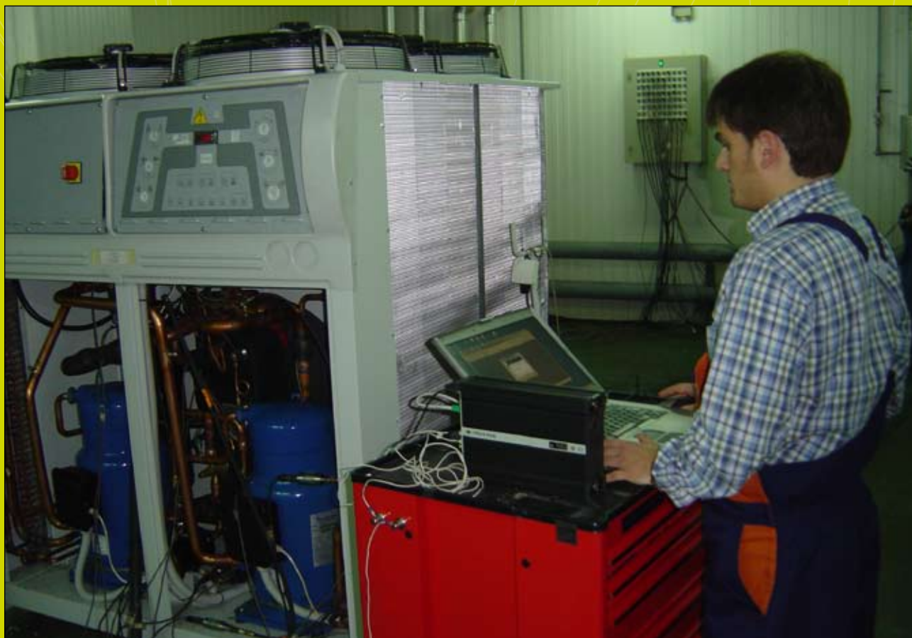
Medición de vibraciones
