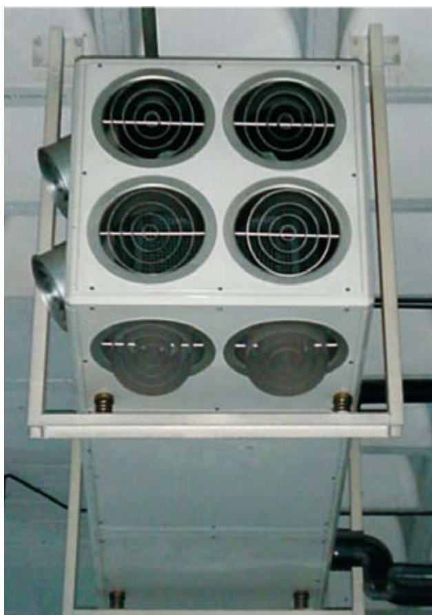
Sistema de ventilación aislada con VIBRABSORBER®
